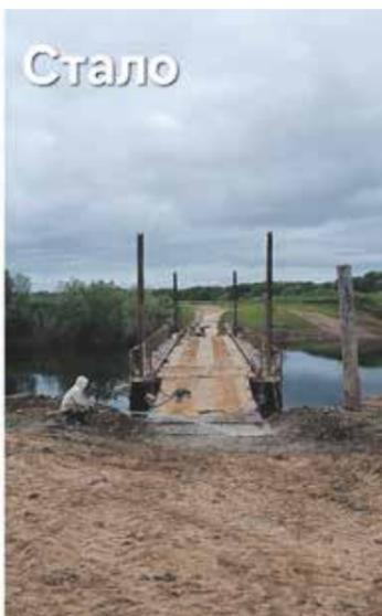
рядчик для обслуживания участка дороги с наплавным мостом. Техническое задание предусматривало установку нового моста с грузоподъёмностью не менее 15 тонн, что делало невозможным использование старых конструкций.
